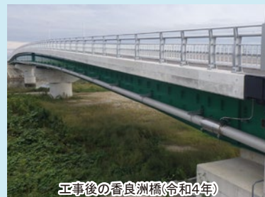
工事後の香良洲橋(令和4年)
