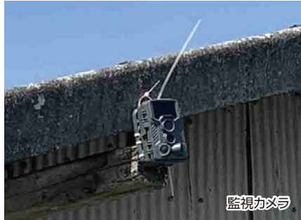
不法投棄防止環境パトロールの様子
