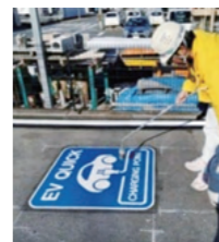
▲ 路面サインはガスバーナーで焼き付けます
