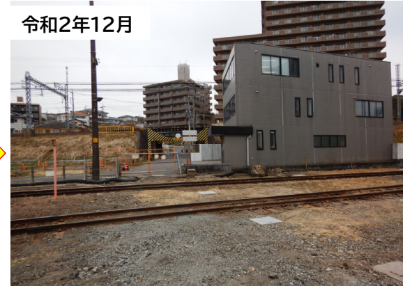
既設踏切撤去状況
