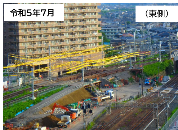
仮桁設置状況
