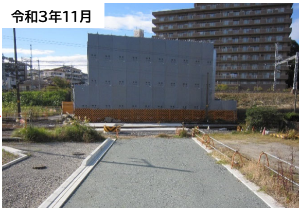
補償物件解体状況
