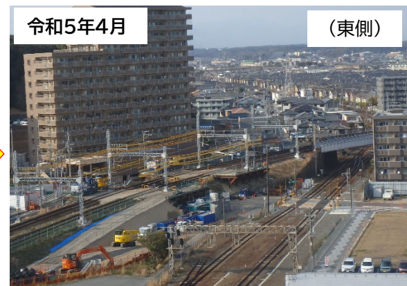
作業用構台設置状況
