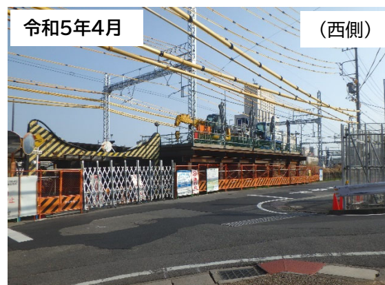
作業用構台設置状況
