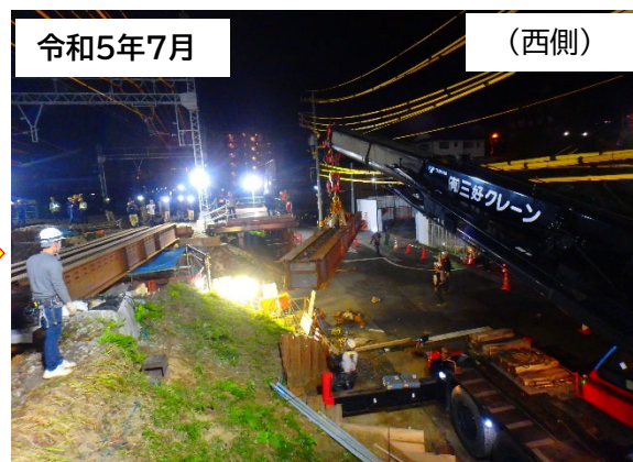
近鉄架道橋 仮桁設置作業
