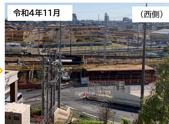
作業用構台設置状況
