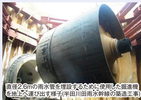
直径2.6mの雨水管を埋設するために使用した掘進機を地上へ運び出す様子(半田川田雨水幹線の築造工事)
