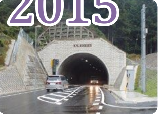
県道一志美杉線矢頭トンネル
