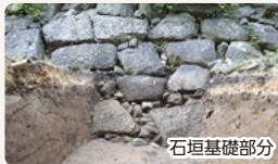
石垣基礎部分
