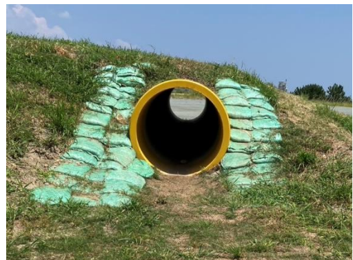
【築山トンネル（山崩れ防止のため芝張）】
