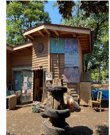
【屋外トイレ付活動小屋】
