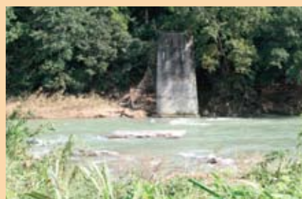
雲出川に残る橋脚
