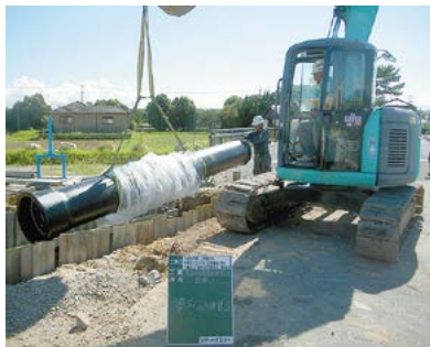
管網整備工事
