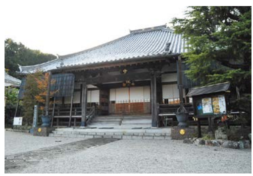
青巖寺本堂全景
