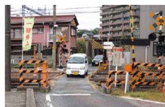
大谷踏切拡幅
