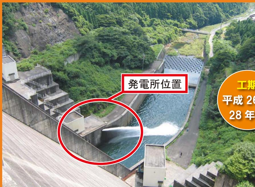
安濃ダムでは、再生可能エネルギーの固定価格買い取り制度を活用し、ダムの放流水を利用した小水力発電所の建設が行われています。
