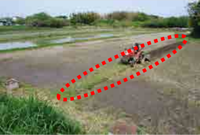
畦畔除去作業
