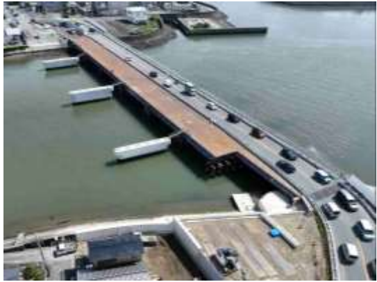
新橋台、橋脚の構築 及び護岸復旧
