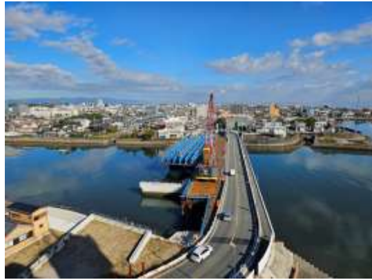
新橋上部工の架設
