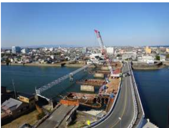
既設橋脚締切作業
