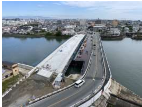
新橋上のコンクリート打設
