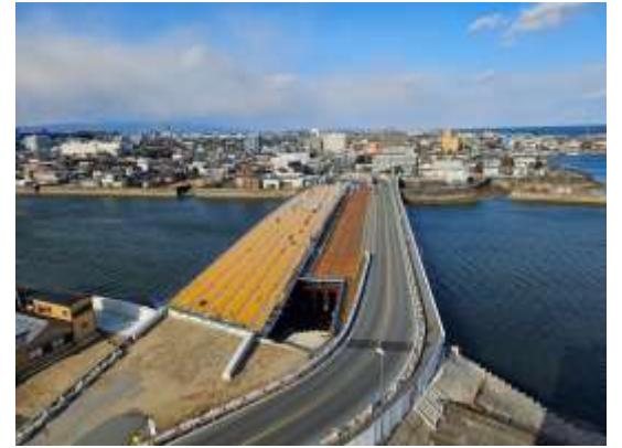
新橋上部工の床版工
