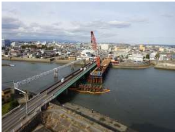
迂回路仮橋・ 工事用仮橋設置作業
