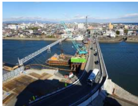
新橋脚 場所打ち杭作業
