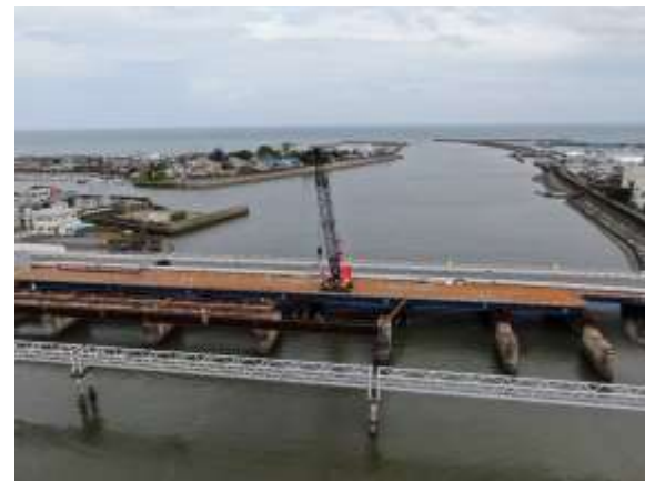
既設上部工撤去作業中
