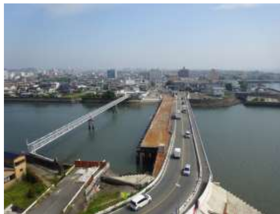
既設橋脚撤去完了
